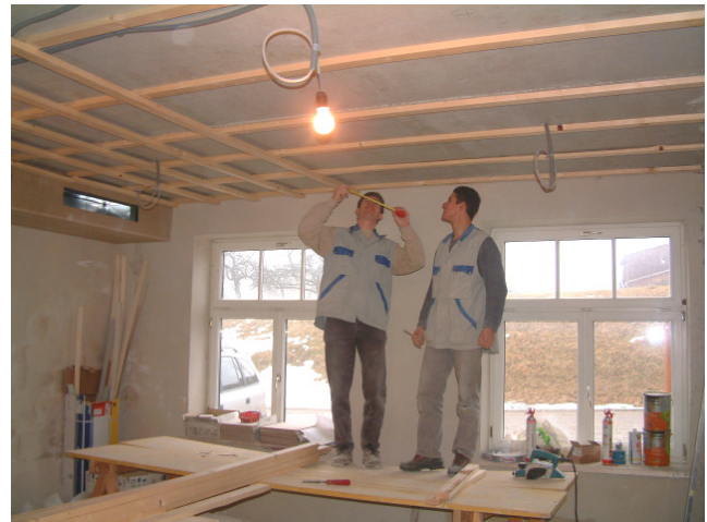
Die Bauarbeiten im neuen „Dorfwirtshaus“ schreiten zügig voran
