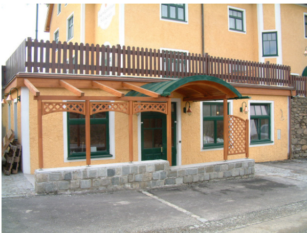
Der Eingang zum neuen „Dorfwirtshaus Sallingstadt“ ist bereits zum Großteil fertig gestellt
