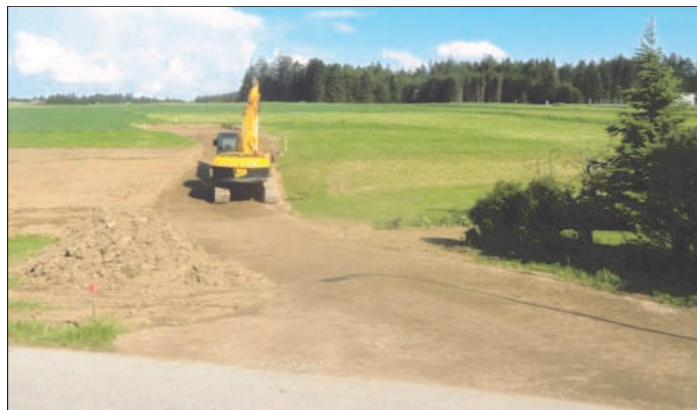
Der Weg ist fertig, der Hausbau kann nun beginnen.
